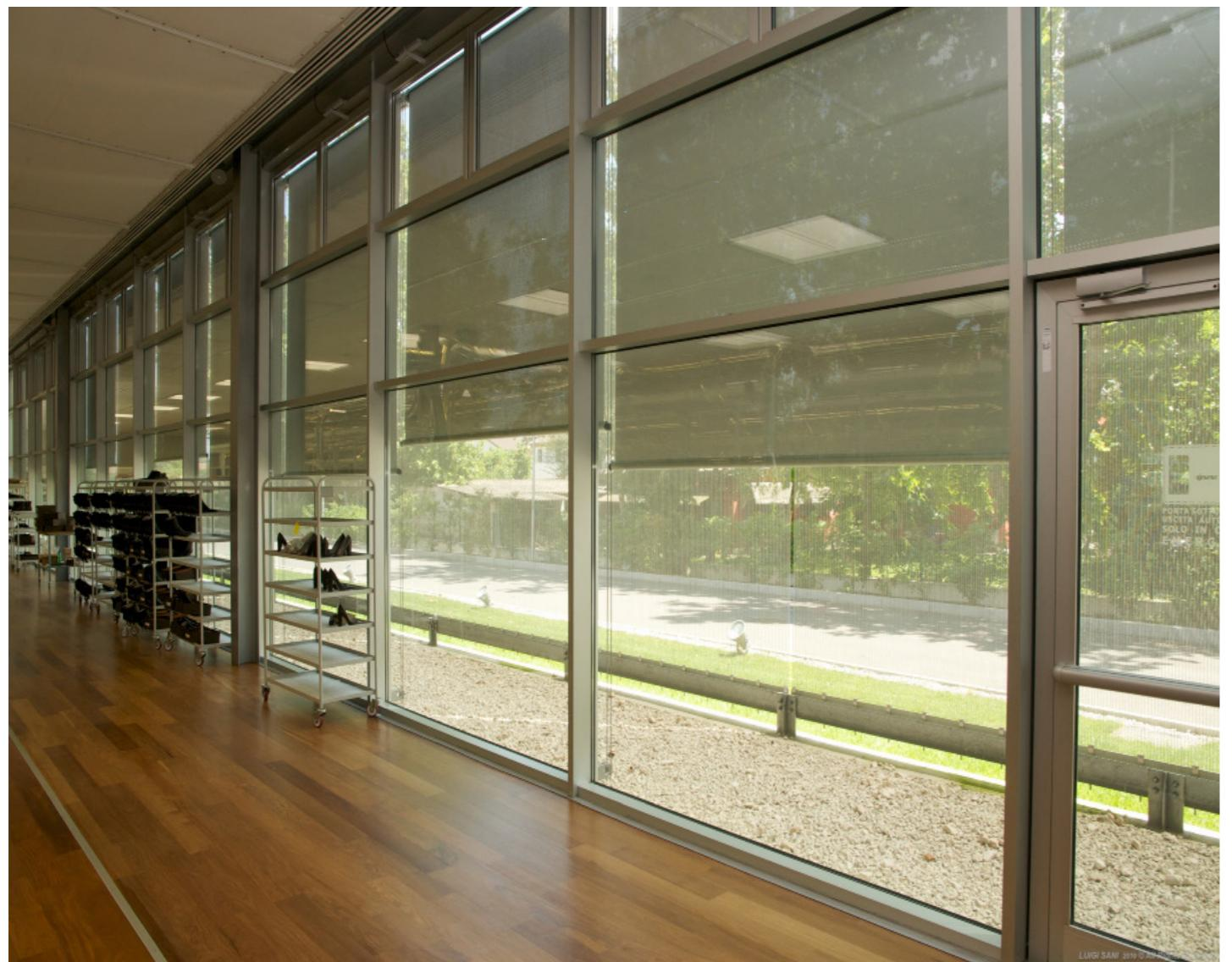
In alcune aree dell'edificio, in presenza dei cavedii, si e' preferito utilizzare una tenda interna tipo 2000, con teli in tessuto Suncoverscreen ad azionamento motorizzato e con profili anodizzati.
